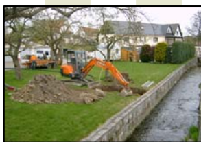
Vorbereitung für Entnahmeschacht
