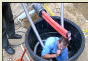
Einbau Vor- u. Rücklauf Sohleleitung
