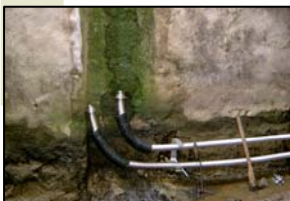
Fließwasserwärmetauscher FWT mit Umlenkeinrichtung
