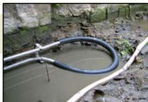
Fließwasserwärmetauscher FWT mit Umlenkeinrichtung
