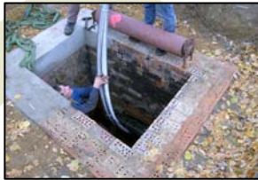
Einzug des Wärmetauschers
