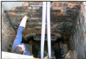
Einschwimmen des Wärmetauschers
